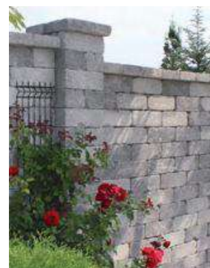
Zidovi i ograde
